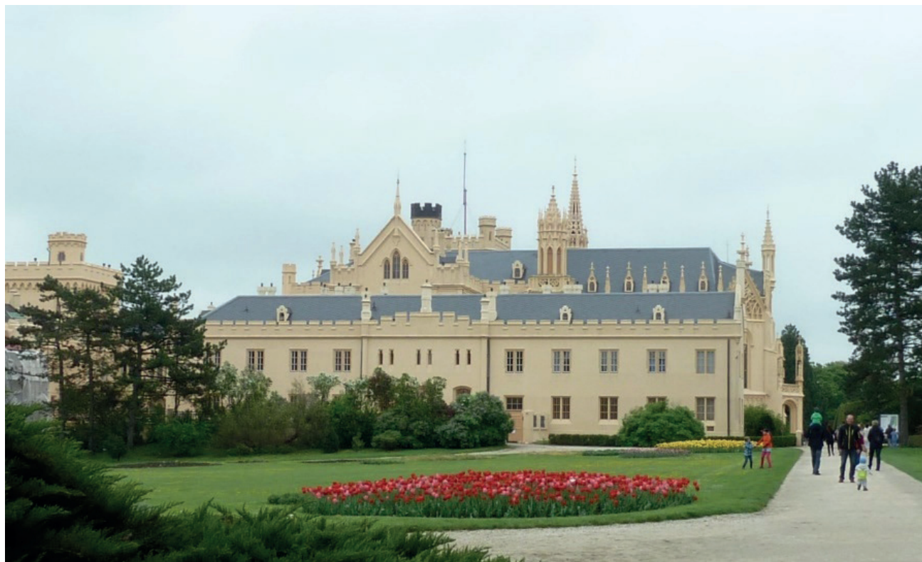
Obr. č. 10: Pohled na zámek Lednice od západu. Foto: Zdeněk Novák, 3. 5. 2013.
