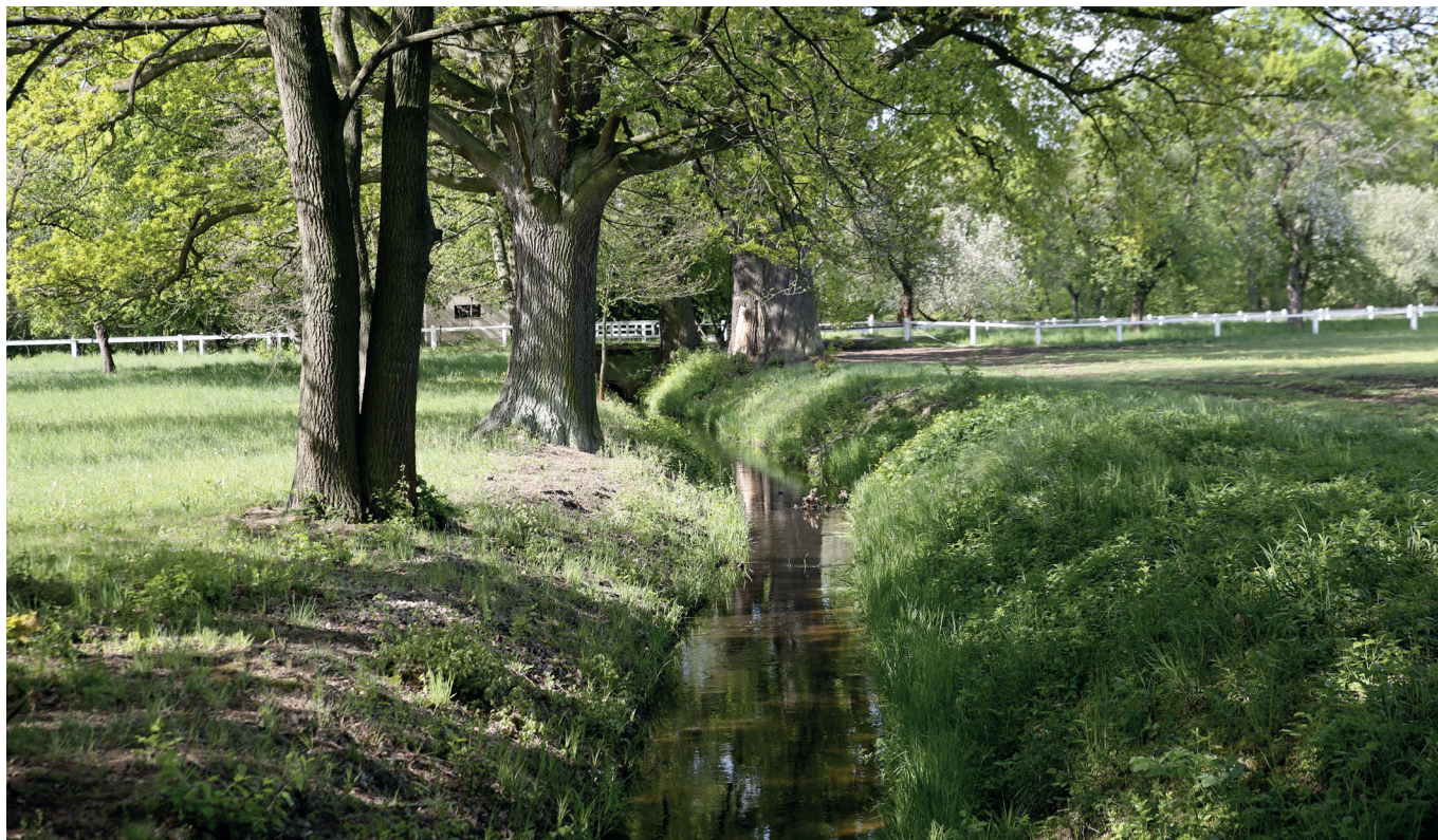
Obr. č. 5: V Krajíně pro chov a výcvik ceremoniálních kočárových koní v Kladrubech nad Labem se do současnosti dochoval výjimečný vodní systém vybudovaný pro zavlažování a odvodňování krajiny, který je hodnotovým atributem. Zdroj: Roman Zámečník, 2023.
