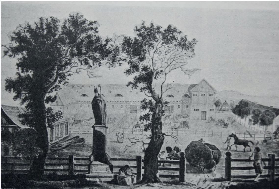
Obr. č. 5: Staré selmické stáje (tzv. Starý kštit) se sochou sv. Gotharda, grafika, 18. století. Světec je stíněn dvěma duby, okolo něj prochází hlavní cesta k selmickým stájím, čerstvě obnoveným po velkém požáru roku 1724. Krajina v celém okolí je jinak dosti otevřená, až na několik (zřejmě na hlavu stříhaných) menších dřevin, neboť aleje začínají doprovázet jednotlivé cesty až v průběhu 19. století. Zdroj: repro fotografie z fondu Národního hřebčína Kladruby.
