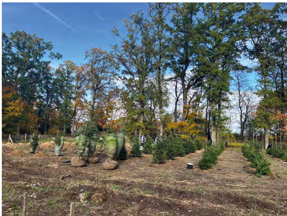
Obr. 10 Probíhající práce na ověření Památkového postupu pro zakládání, stabilizaci a zajištění vegetačních stěn v krajinářských parcích – zakládání vegetační stěny v Průhonickém parku. Zdroj: foto Jiří Šmída (2023).
